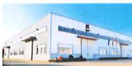
AMES WUHU Wuhu County (China) Fabricación de componentes mecánicos Centro de Distribución 2017
